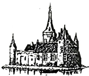
Kastell zu Kervendonk · Kervenheim
